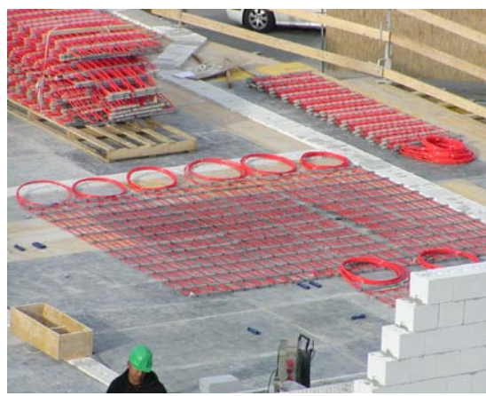
Dunakeszi: általunk tervezett és épített társasház mennyezeti fűtő-hűtő panelek elhelyezése a vb. födém zsaluzatába: a panelek előregyártott formában érkeznek a helyszínre.
