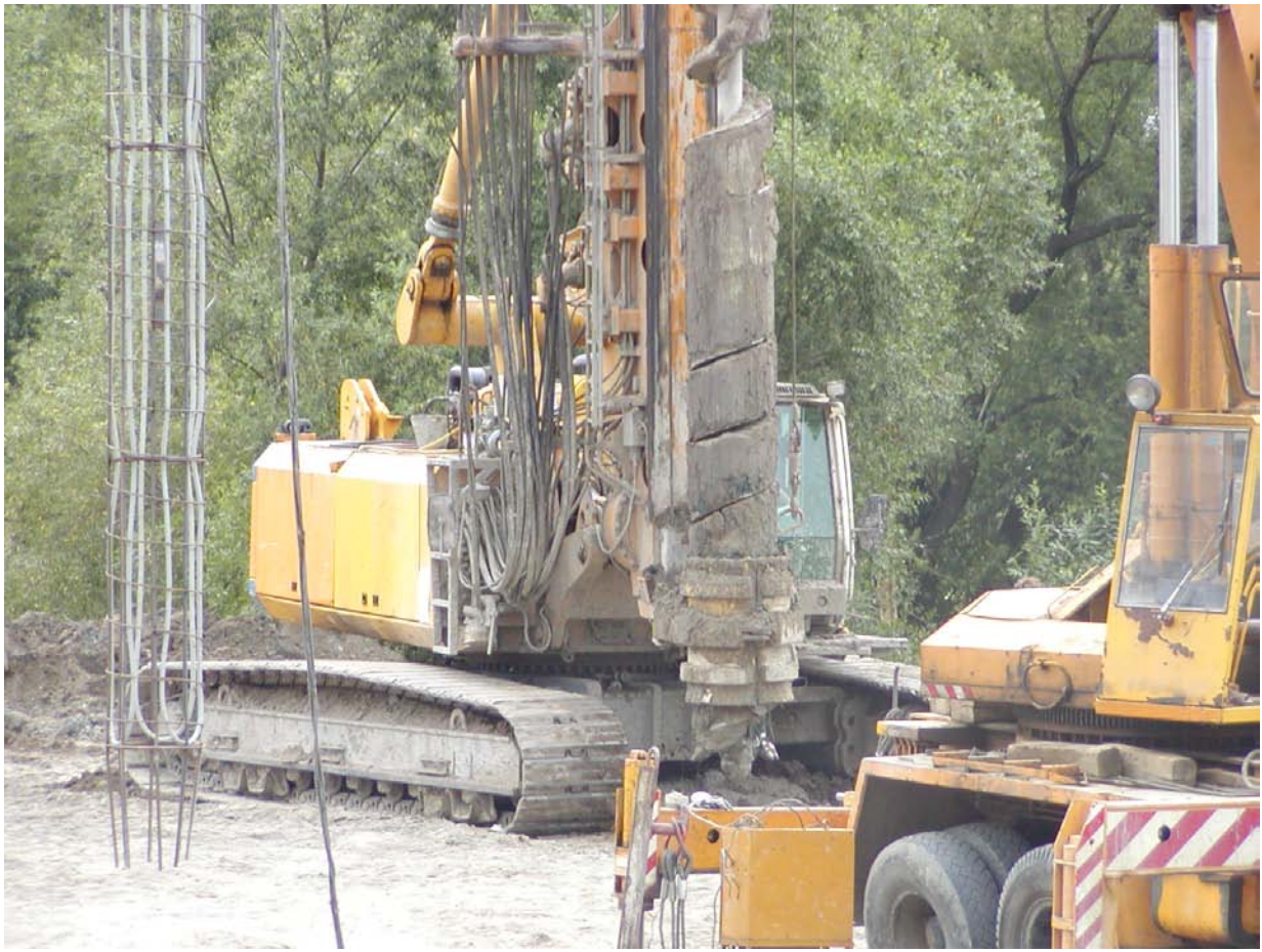
Függőleges szonda telepítése az 5-let Kft egyik építkezésén 2005-ben
